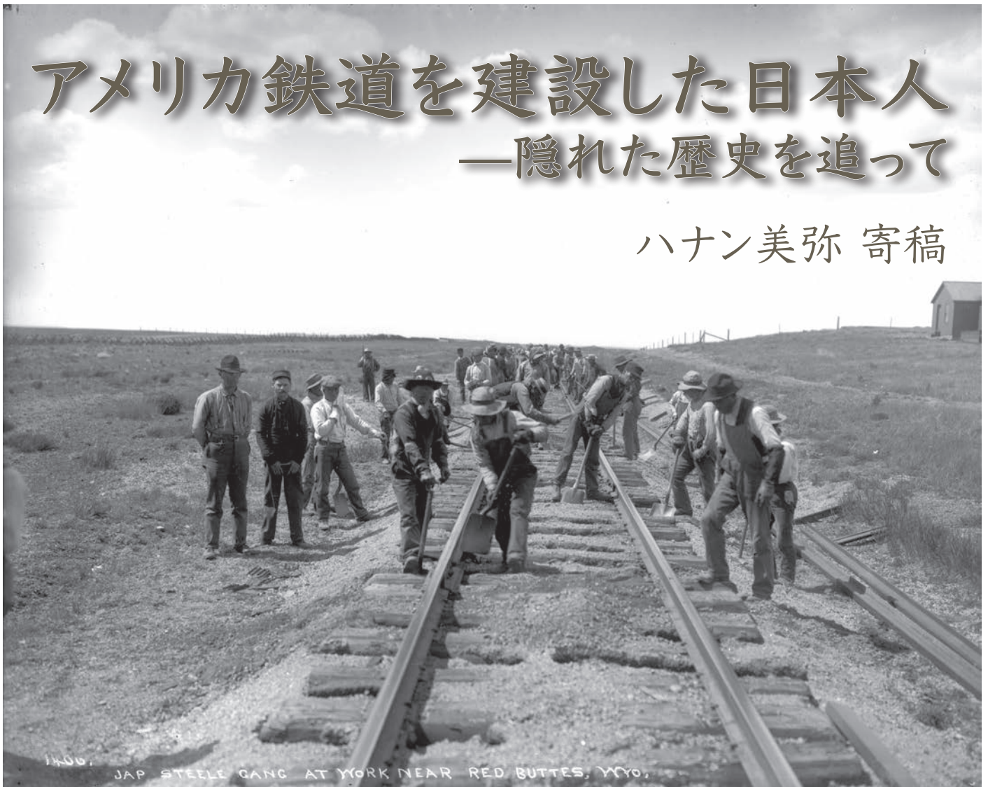
日本人ギャング、線路のレールを入れ替えている様子。
